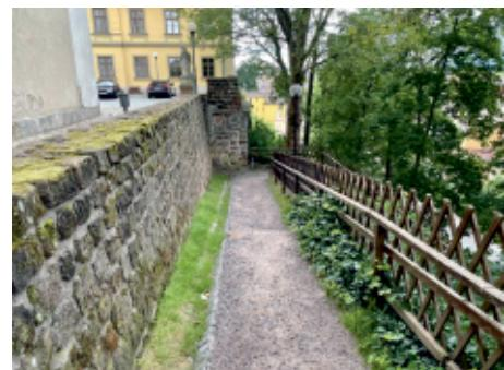
Město zde kompletně vyměnilo všechny dřevěné prvky zábradlí a část dožilých zkorodovaných sloupků. Ty, co jsou ještě v pořádku, ošetří a natře. „Opravíme také mlatové chodníky, včetně rozpadlých konstrukčních vrstev, a žulový dlážděný žlab. Dále vyměníme již nevyhovující pískovcové schody, a abychom zabránili vodní erozi, dobudujeme příčné kostkové pruhy,“ popisuje průběh Vlastimil Grof z Odboru rozvoje města MěÚ Trutnov.
